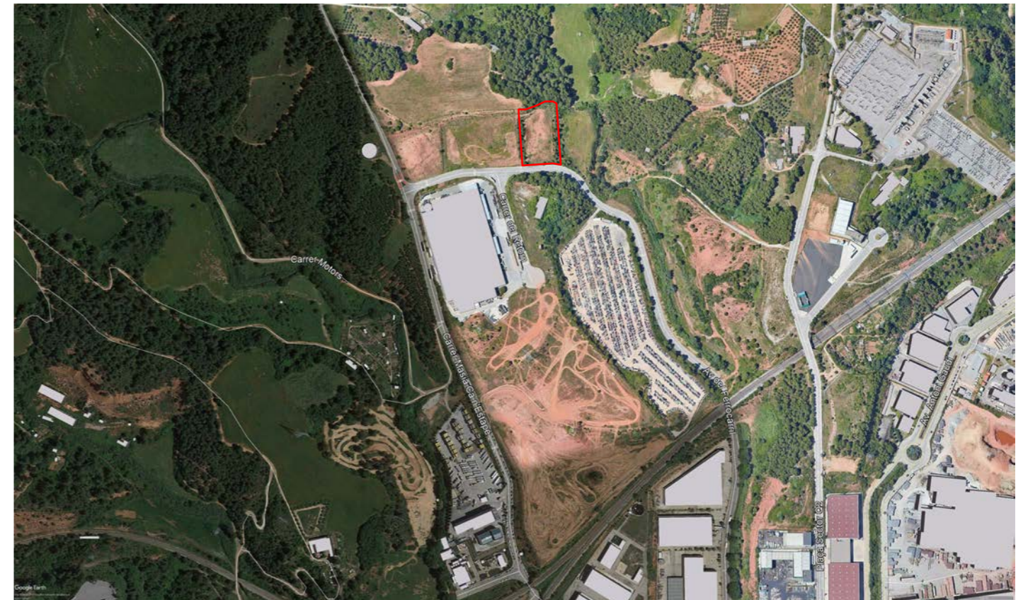
Fotografía aérea de emplazamiento
